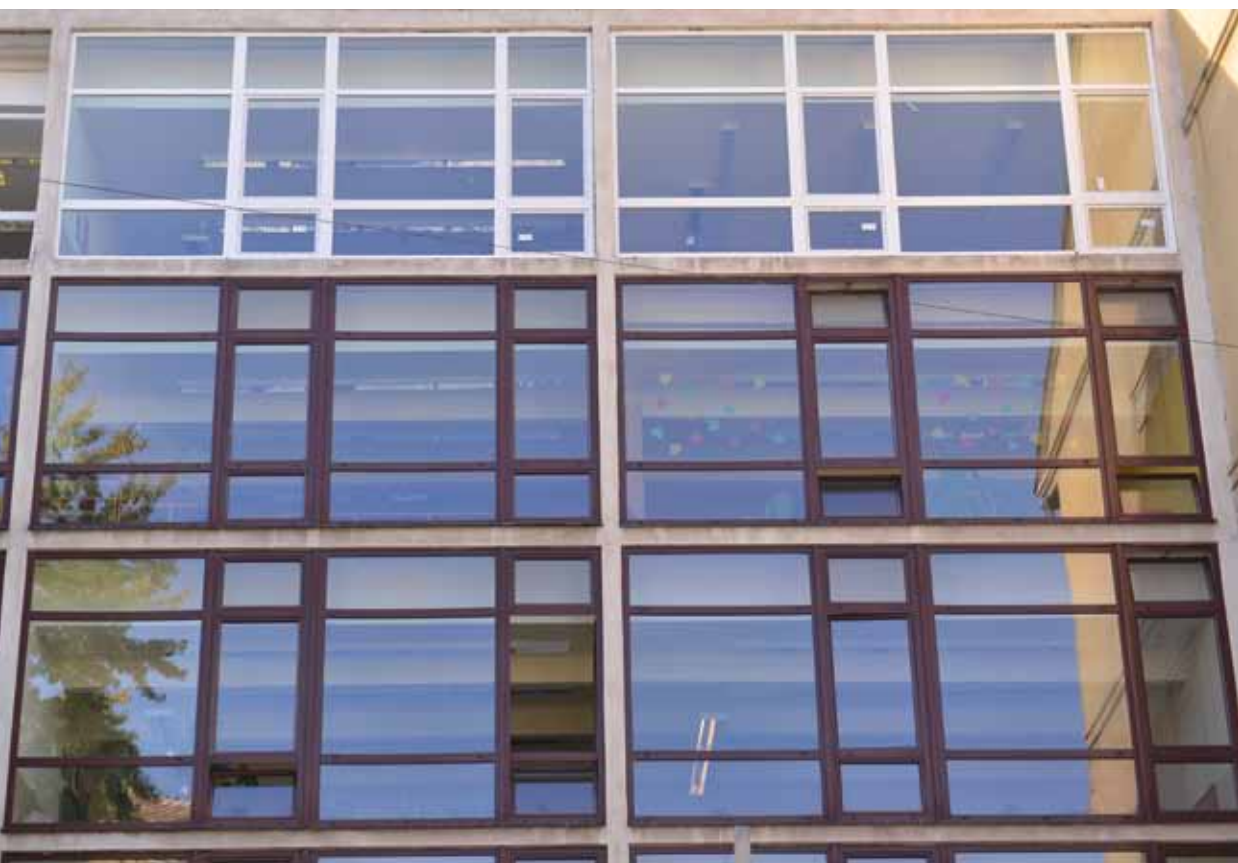
Az iskola nyílászáróinak cseréje is megtörtént
